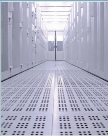
Die Kaltgangeinhausung ist eine hochmoderne Lösung für Energieeffizienz und Kaltluftverteilung.
