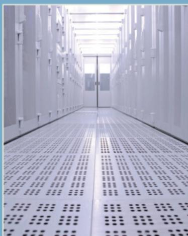
Die Kaltgangeinhausung ist eine hochmoderne Lösung für Energieeffizienz und Kaltluftverteilung.
