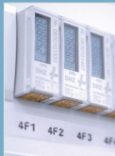
Zertifizierte Strommessgeräte je Kunde und Schaltkreis zur Überwachung und Abrechnung.
